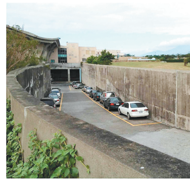
圖三：抬高四公尺再進入地下室 的防洪坡車道。(圖/劉銘欽提供)
